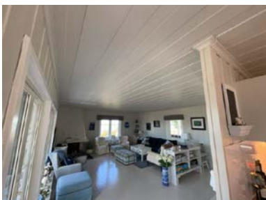
Utsnitt gjenbygd takkonstruksjon.
