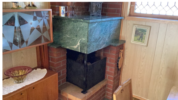
Peis uten synlig pipeløp.
