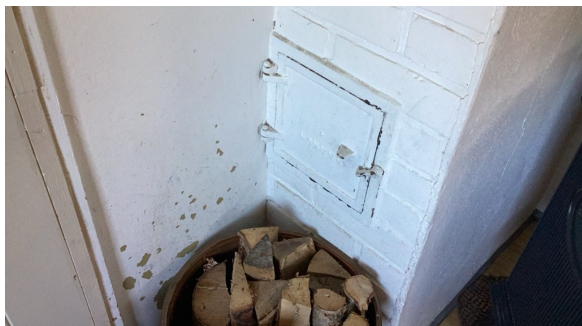
Sotluke på kjøkken.
