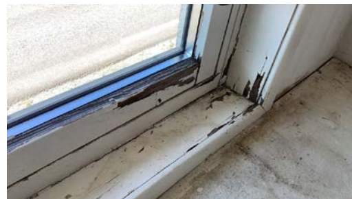
Eksempel på slitasje.
