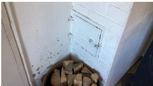
Sotluke på kjøkken.
