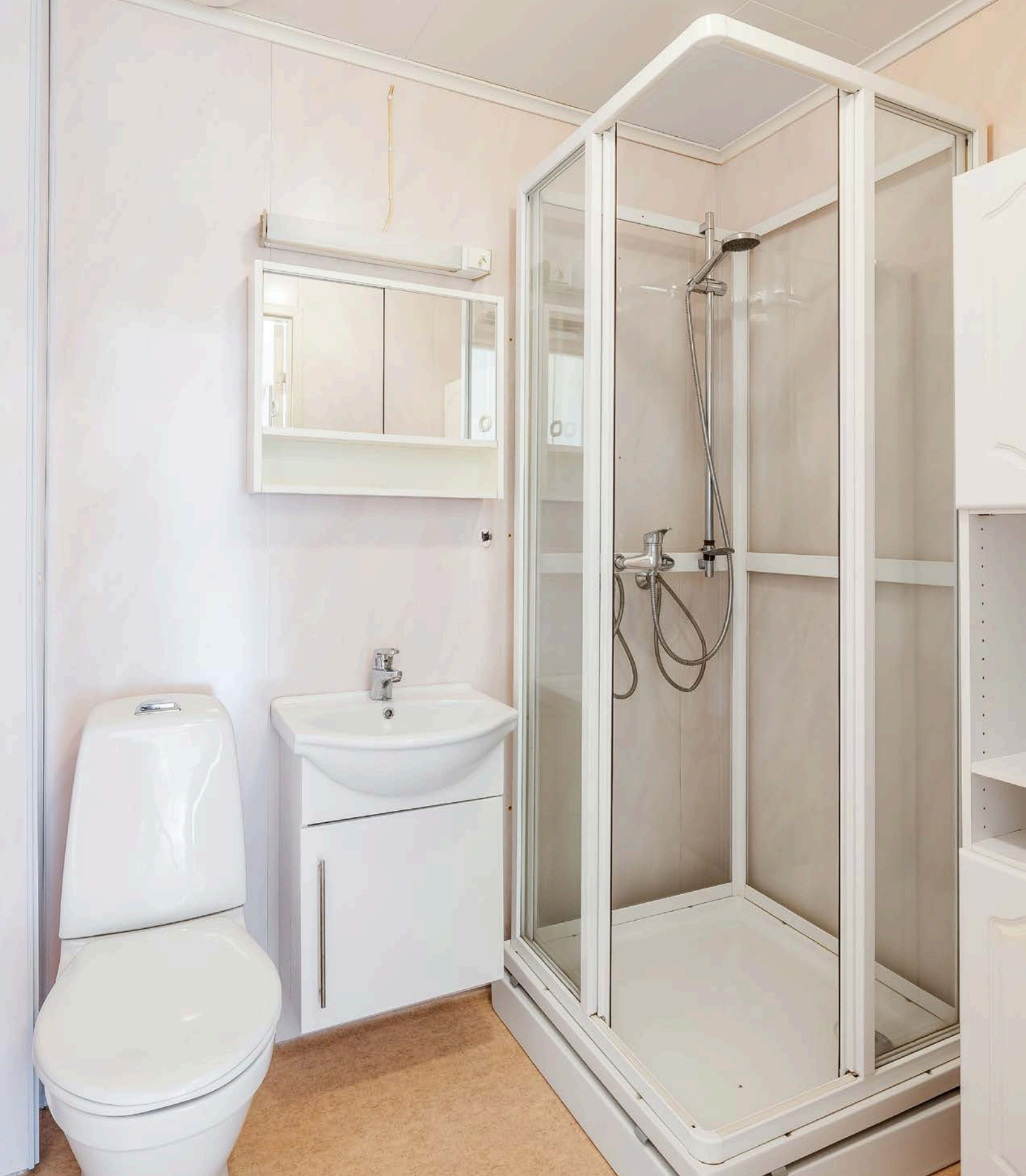
Eldre baderom i hybelleiligheten med belegg på gulv og våtromsplater på veggene. Baderommet er utstyrt med servantskap, speilskap med belysning over, dusjkabinett og gulvstående toalett.
