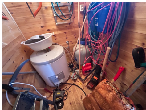
Stoppekran/trykktank/varmtvannsbereder.
