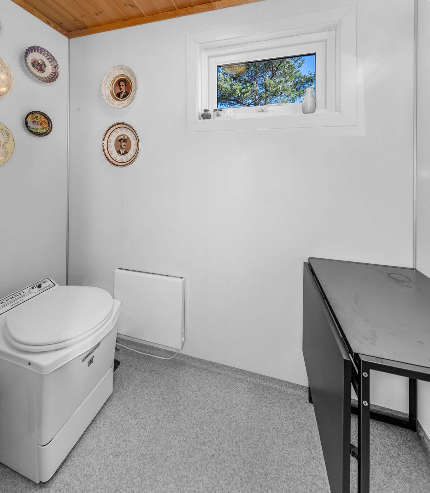
Toalettrom inneholder cinderella forbrenningstolett.
