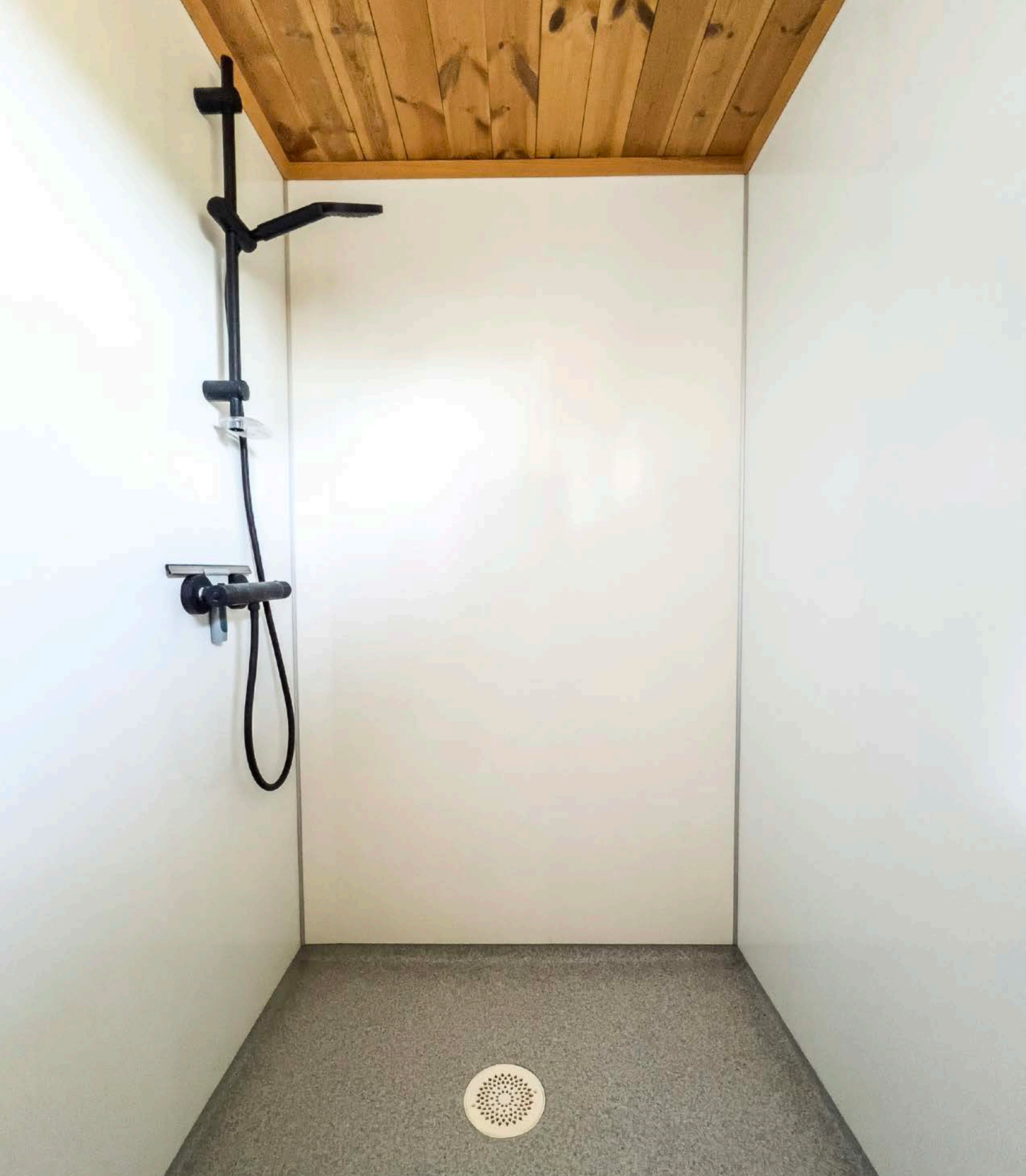
Bad (dusjrom) med belegg på gulv.
