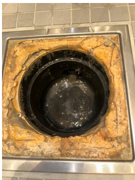
Sluk med vannlås, plassert i dusjnisje
