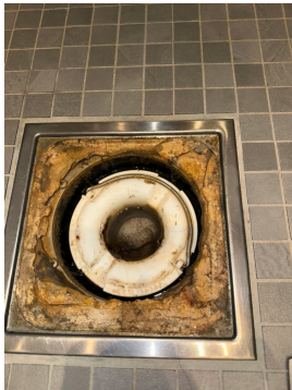
Sluk med vannlås, plassert i dusjnisje
