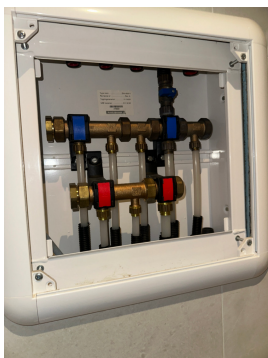
Røropplegg i kjøkkenbenk med Waterguard
