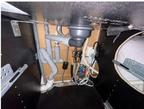
Røropplegg i kjøkkenbenk med Waterguard
