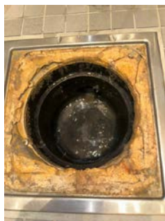
Sluk med vannlås, plassert i dusjnisje
