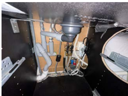
Rørapplegg i kjøkkenbenk med Waterguard
