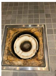
Sluk med vannlås, plassert i dusjnisje
