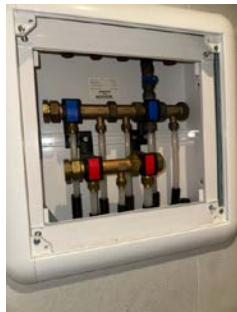
Rørapplegg i kjøkkenbenk med Waterguard
