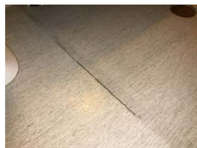
Belegg er løst fra gulvet og har sprekker.
