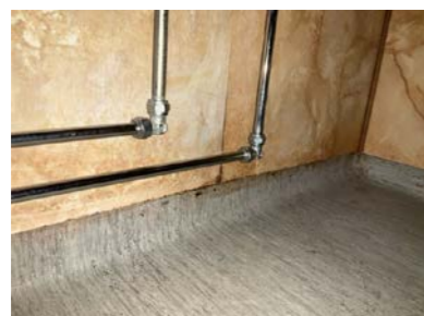
Belegg er løst fra gulvet og har sprekker.
