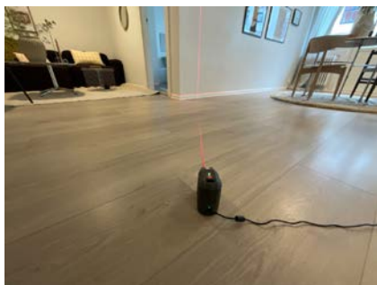
Nivellering stue + soverom, ingen avvik registrert
