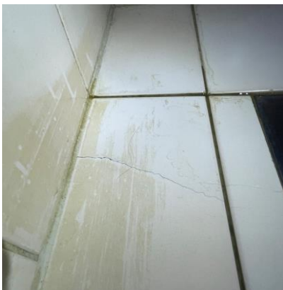
Sprekk flis
