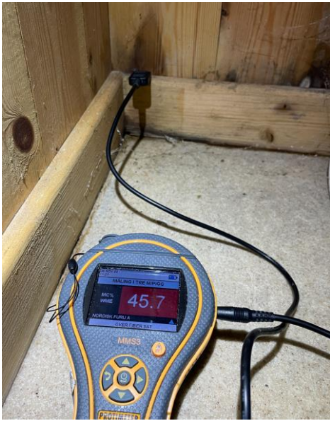
Fuktmåling rom under terreng panel
