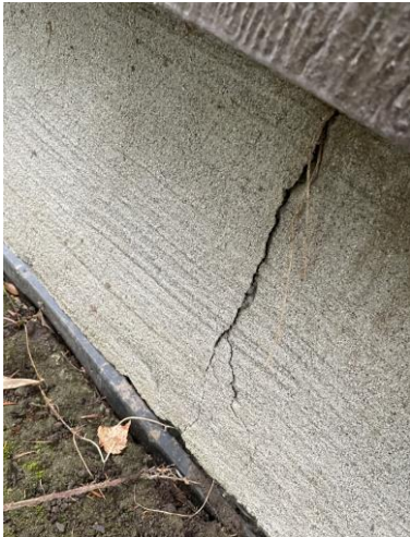
Sprekk grunnmur
