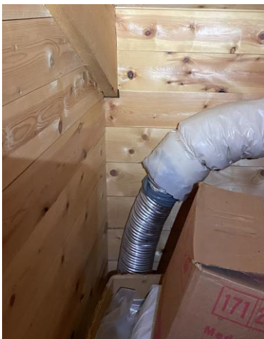
Uisolert vent.
