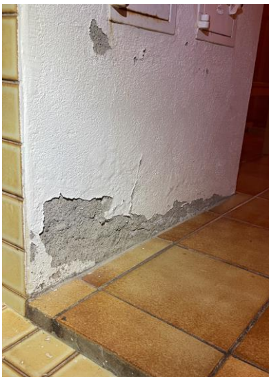
Avskalning murvegg/pipe
