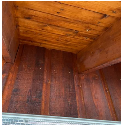
tett lufting mellom sperrer utv.
