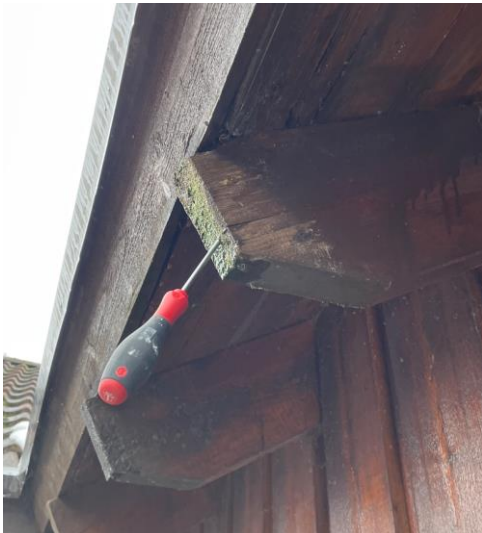
Råteskadet sperreende
