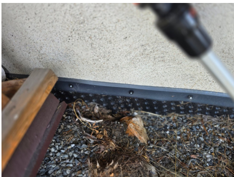
Grunnmursplast på mur i tilbygget.-
