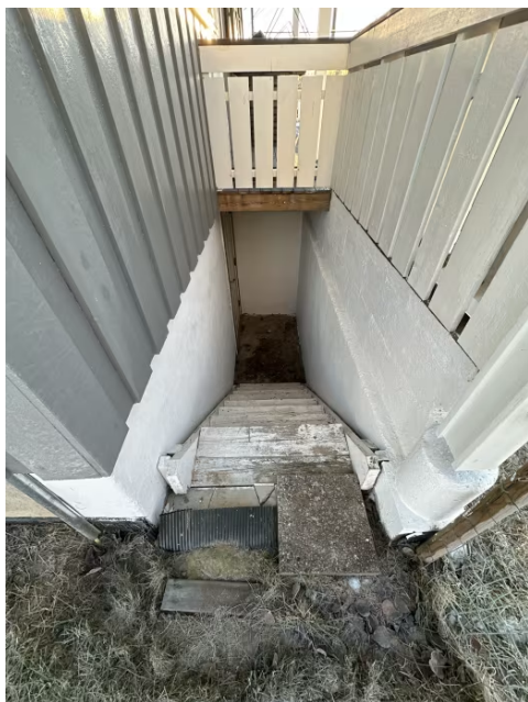
Viser trappeløp til kjeller.
