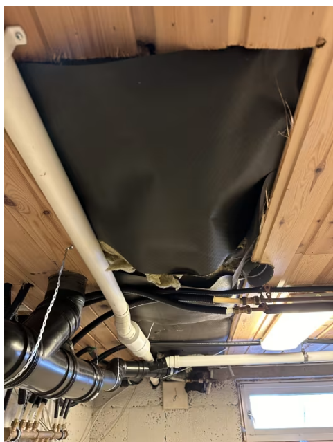
Viser åpen himling i kjeller.
