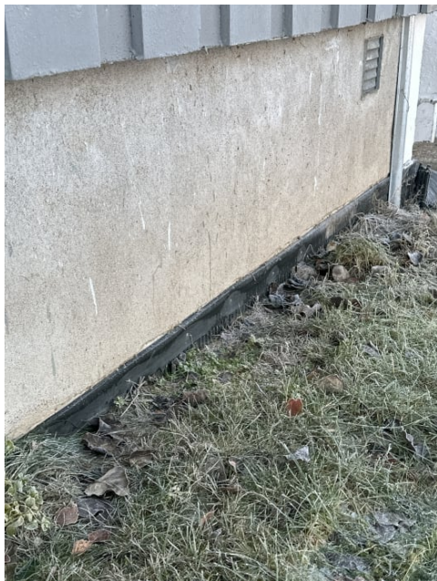
Viser drensplater klemt med topplis.
