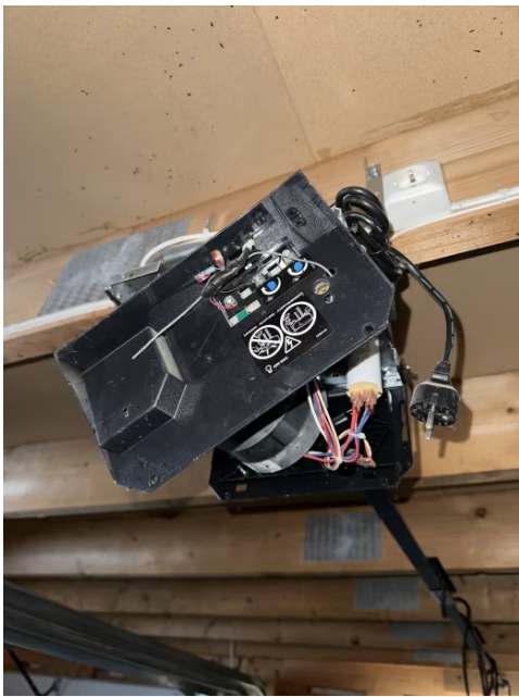
Motor for leddport er defekt.
