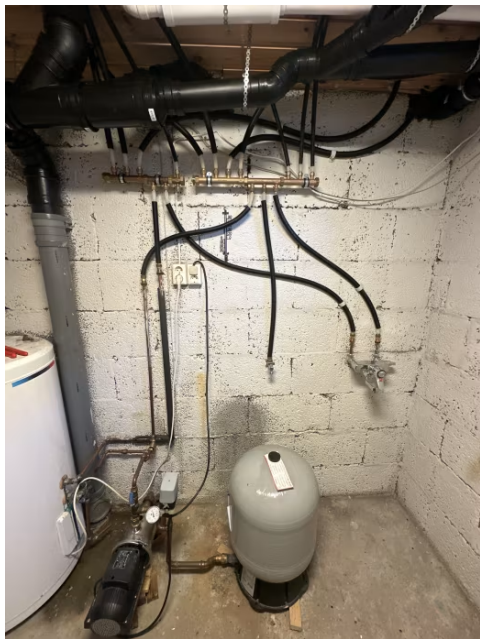
Viser Hydroforanlegg med pumpe, trykktank, vegghegte fordelere og hovedstoppekran..
