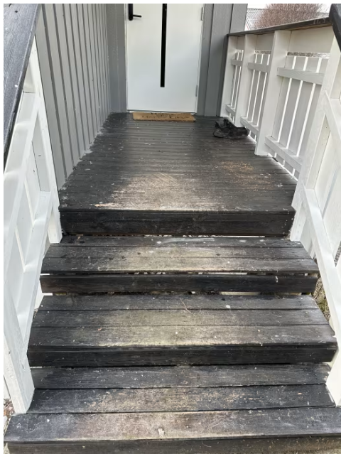
Viser trapp ved hovedinngang.
