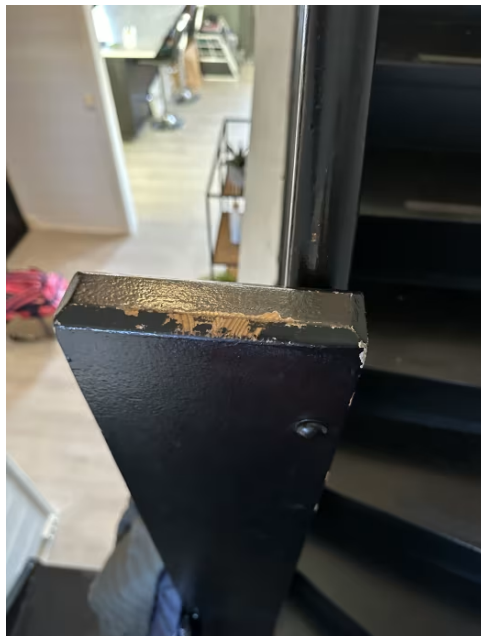
Registrert malingsavflassing på rekkverk.
