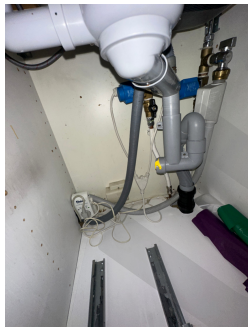
Røropplegg i kjøkkenbenk med Waterguard
