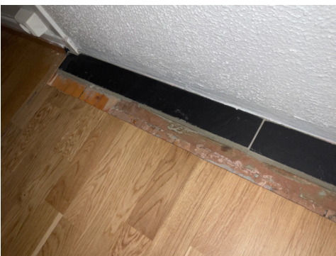
I stuen, mot pipen
