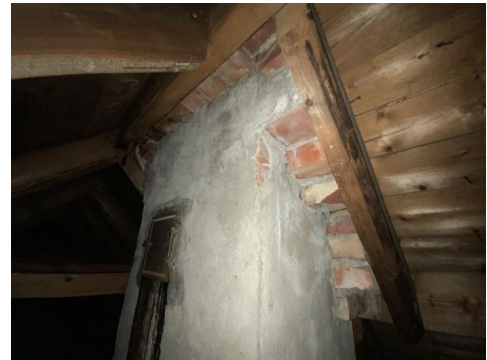
Kontroll rundt pipeløp.
