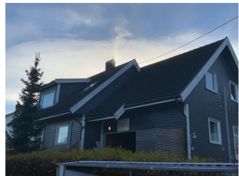
Besiktigelse av taktekke.
