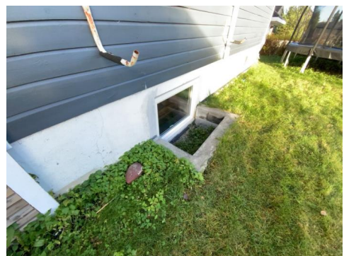
Kontroll av drenering/fuksikring.
