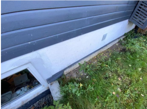
Kontroll av drenering/fuktsikring.
