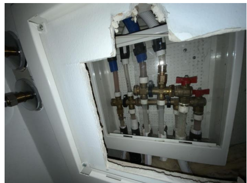
Besiktigelse av røropplegg.
