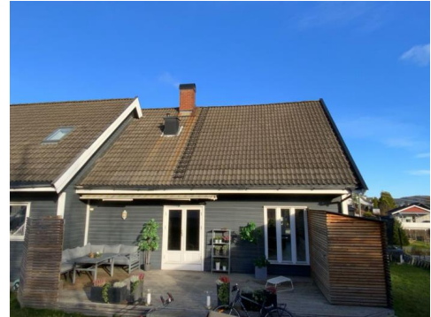
Besiktigelse av taktekke.
