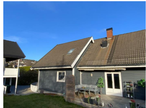
Besiktigelse av taktekke.
