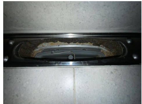
Kontroll av sluk.
