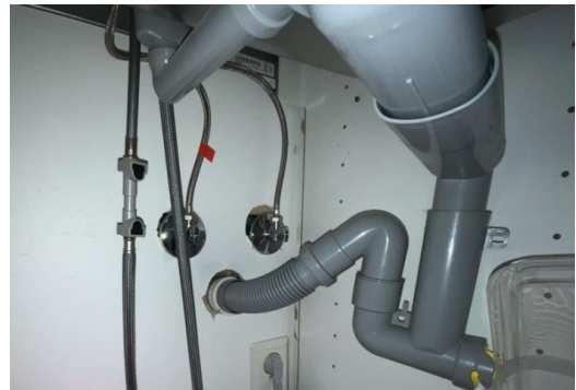
Besiktigelse av røropplegg.
