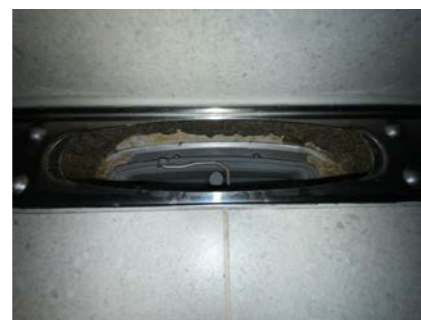
Kontroll av sluk.
