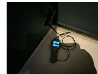
Utført hulltaking på rom under terreng.
