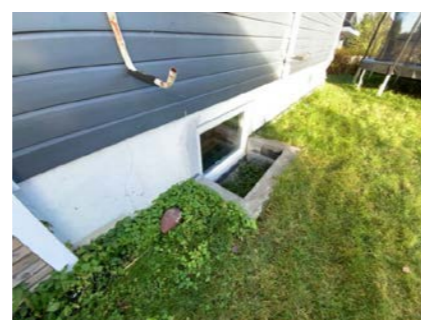
Kontroll av drenering/fuktsikring.
