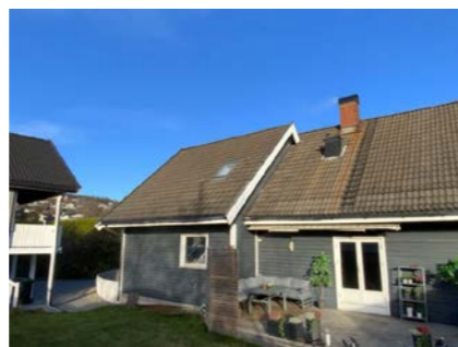
Besiktigelse av taktekke.
