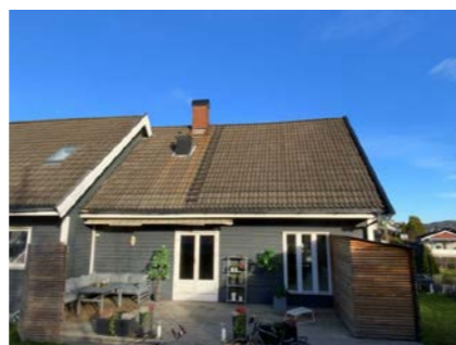
Besiktigelse av taktekke.
