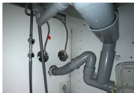
Besiktigelse av røropplegg.
