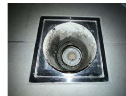
Kontroll av sluk.
