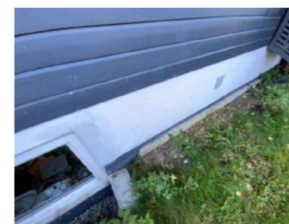
Kontroll av drenering/fuktsikring.
