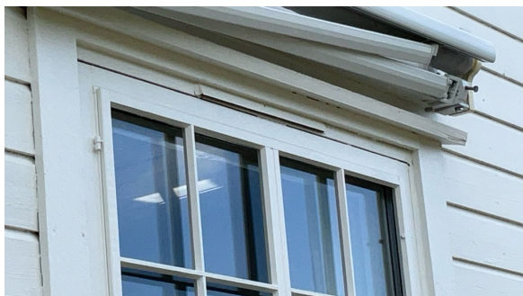
Eksempel på montert ventil i vindu.
