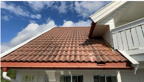
Del av taktekkning.
