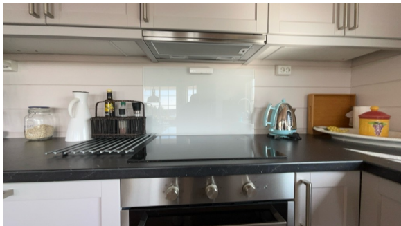
Montert avtrekk over steketopp.
