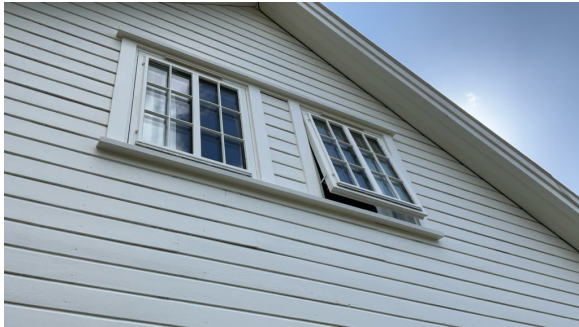
Eksempel på vindu i yttervegg.
