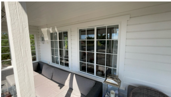
Eksempel på vindu i yttervegg.
