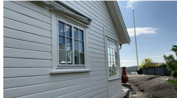
Eksempel på vindu i yttervegg.
