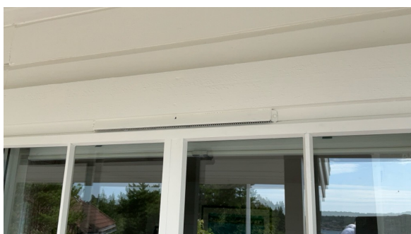
Eksempel på montert ventil i vindu.
