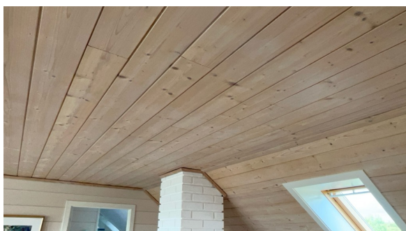
Tak sett fra innsiden.
