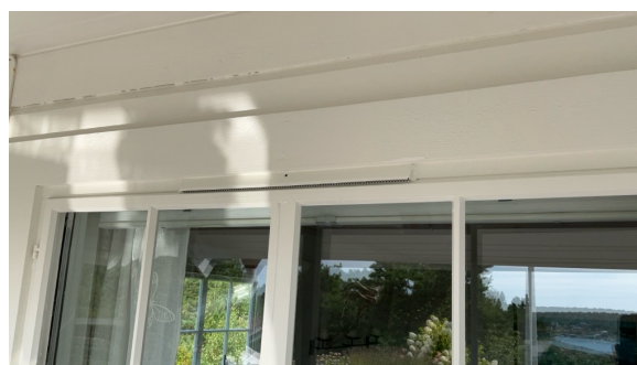
Eksempel på montert ventil i vindu.
