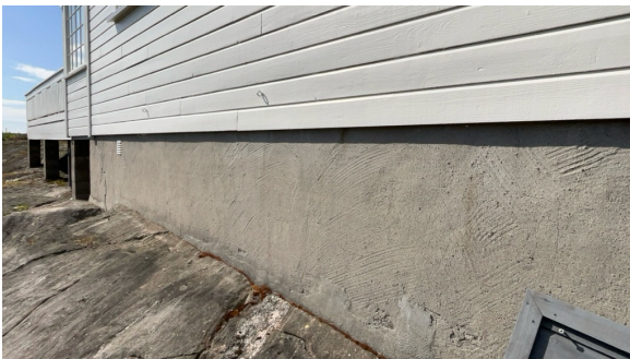
Del av grunnmur.
