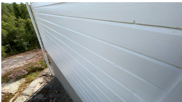
Del av vegg.
