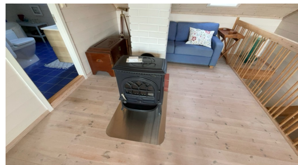
Montert ovn i stue 2 etasje.
