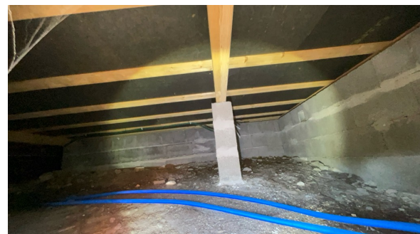
Del av etasjeskille sett fra krypkjeller.
