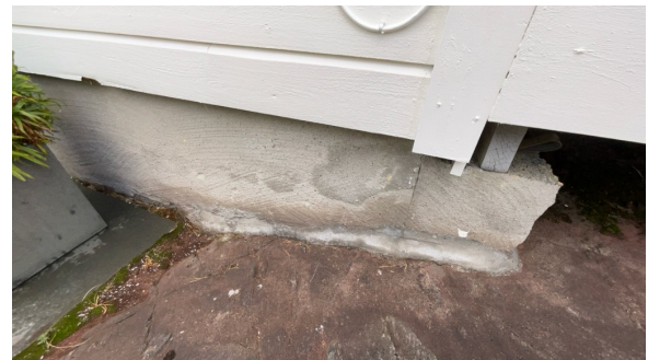
Del av grunnmur.
