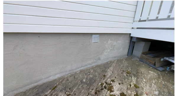
Del av grunnmur.
