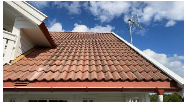
Del av taktekkning.
