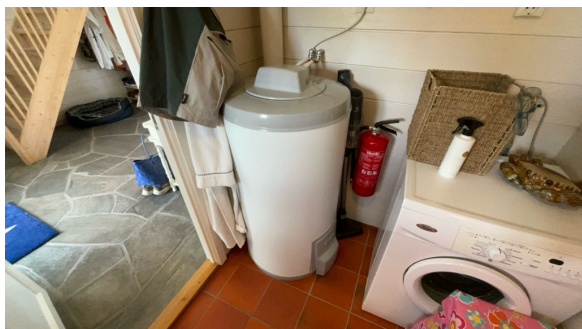
Varmtvannstank.
