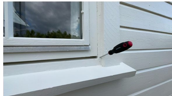
Stikk kontroll på vinduer er utført.
