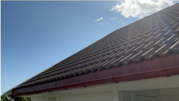
Del av taktekkning.
