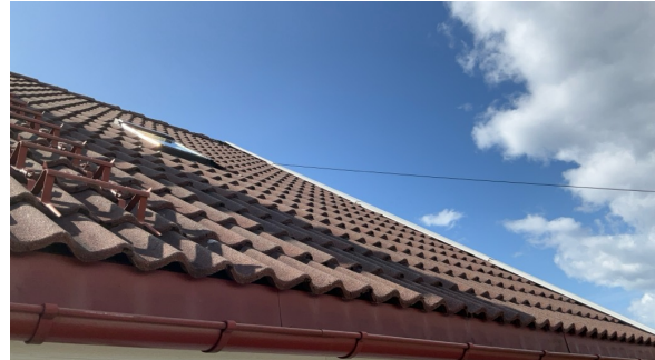
Del av taktekkning.
