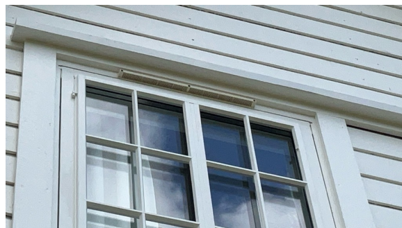
Eksempel på montert ventil i vindu.
