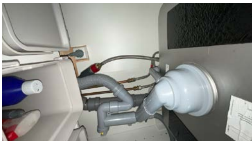
Del av rør til vann.
