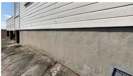
Del av grunnmur.
