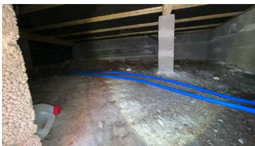
Del av krypkjeller.
