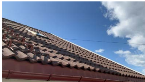
Del av taktekking.
