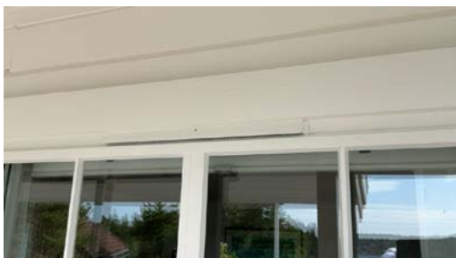
Eksempel på montert ventil i vindu.
