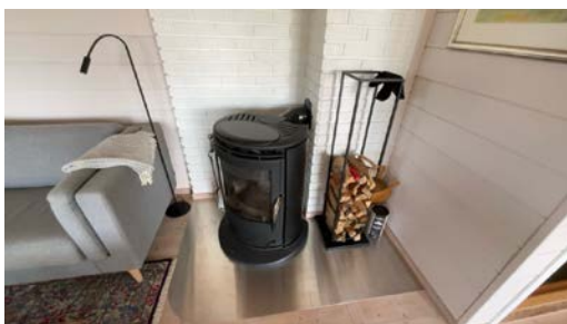
Montert ovn i stue.
