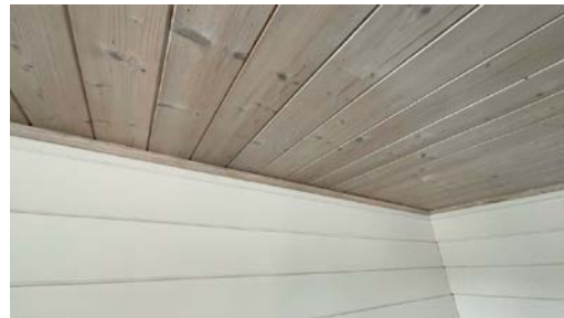
Del av vegg - tak.
