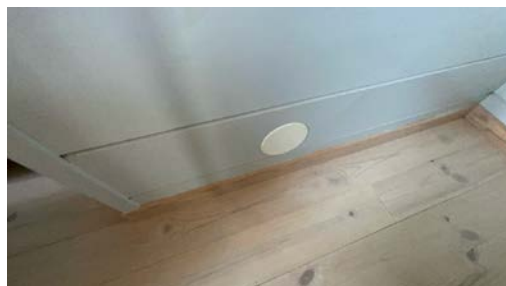
Lokk over hull.
