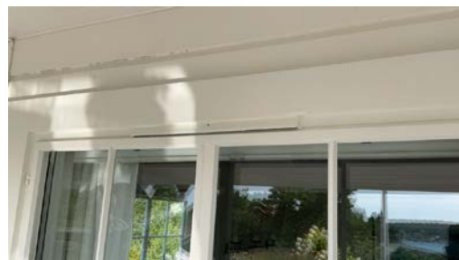
Eksempel på montert ventil i vindu.
