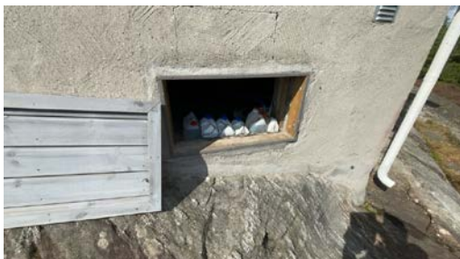
Luke inn til krypkjeller.
