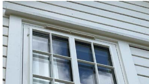
Eksempel på montert ventil i vindu.
