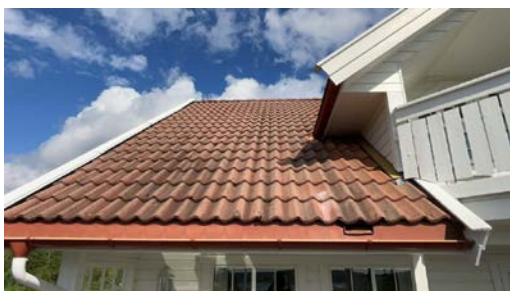
Del av taktekking.
