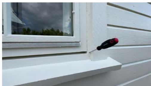
Stikkontroll på vinduer er utført.
