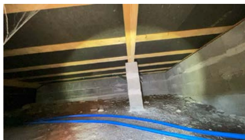
Del av etasjeskille sett fra krypkjeller.
