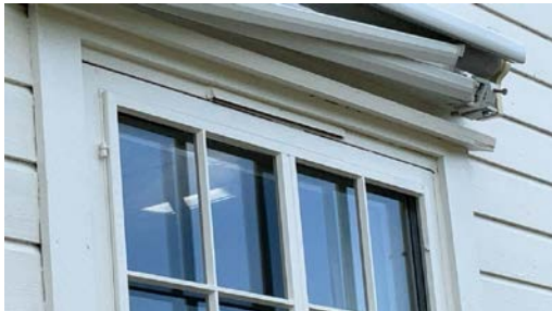
Eksempel på montert ventil i vindu.
