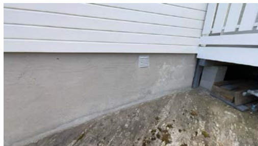
Del av grunnmur.
