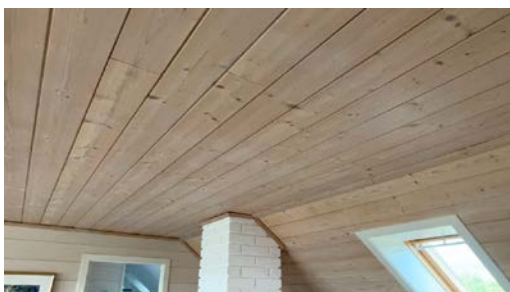
Tak sett fra innsiden.
