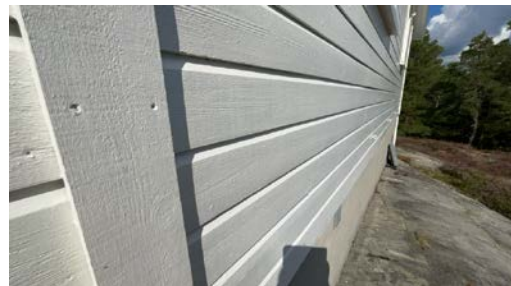
Del av vegg.
