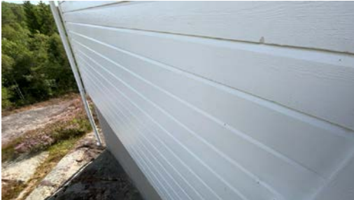
Del av vegg.
