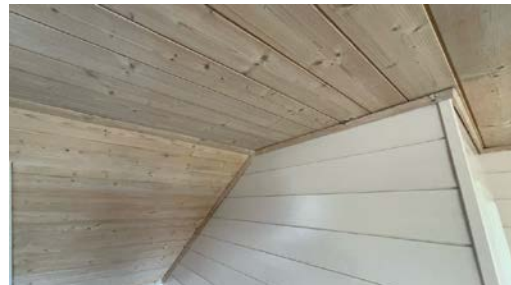
Del av vegg - tak.
