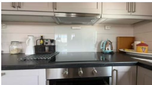
Montert avtrekk over steketopp.
