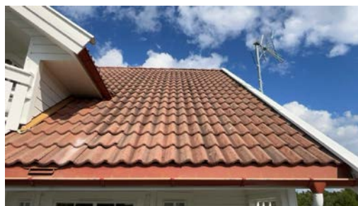
Del av taktekking.
