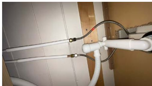
Del av rør til vann.
