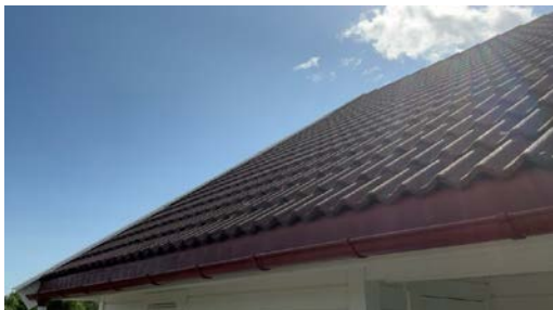
Del av taktekking.
