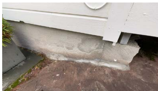
Del av grunnmur.
