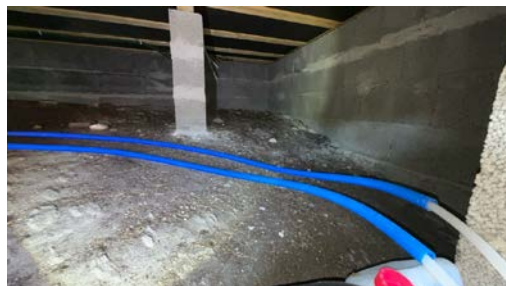
Del av krypkjeller.
