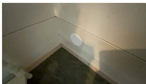
Lokk over hull.
