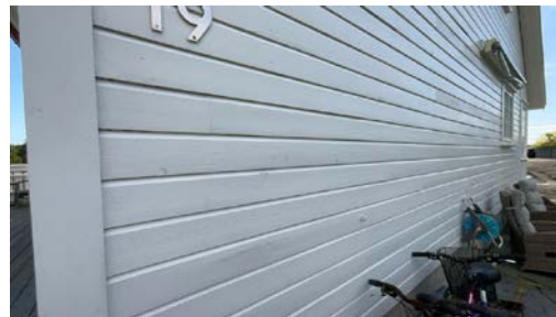
Del av vegg.
