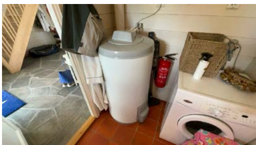
Varmtvannstank.
