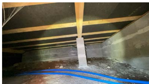
Del av etasjeskille sett fra krypkjeller.
