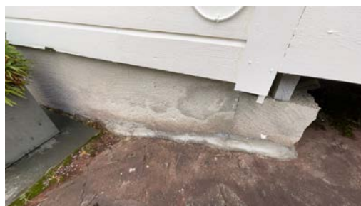
Del av grunnmur.
