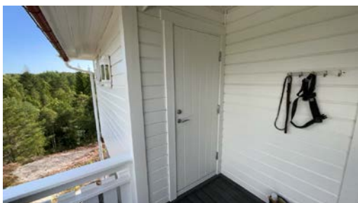
Dør inn til bod.
