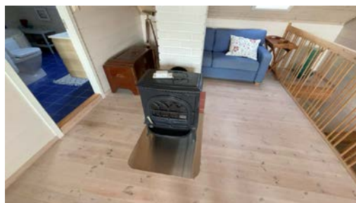
Montert ovn i stue 2 etasje.
