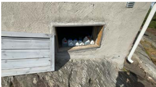
Luke inn til krypkjeller.
