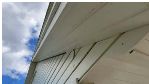
Del av gesims.
