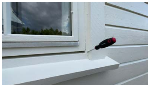
Stikkontroll på vinduer er utført.
