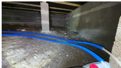
Del av krypkjeller.
