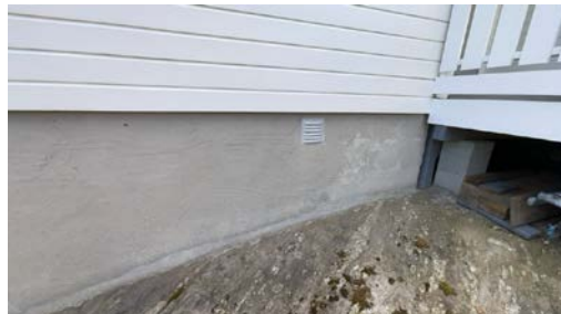
Del av grunnmur.
