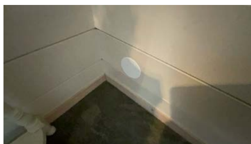
Lokk over hull.
