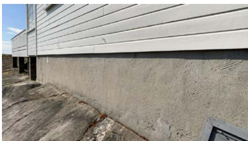
Del av grunnmur.
