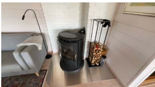
Montert ovn i stue.
