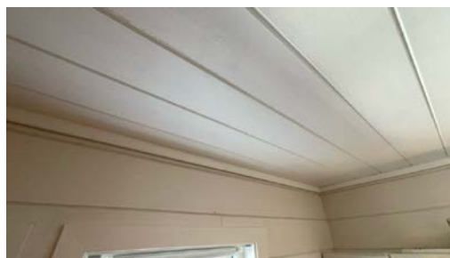
Del av vegg - tak.
