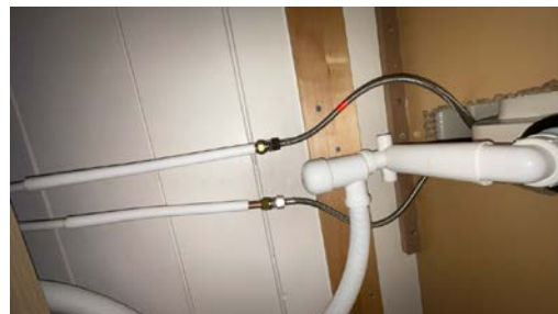
Del av rør til vann.
