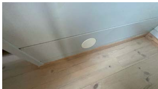
Lokk over hull.
