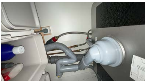
Del av rør til vann.
