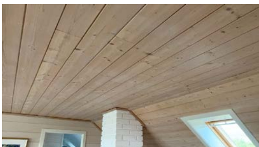
Tak sett fra innsiden.
