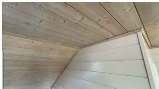
Del av vegg - tak.
