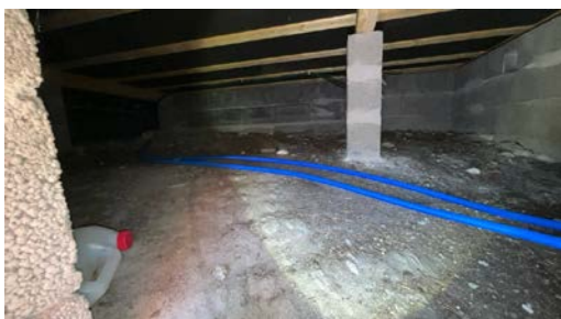
Del av krypkjeller.
