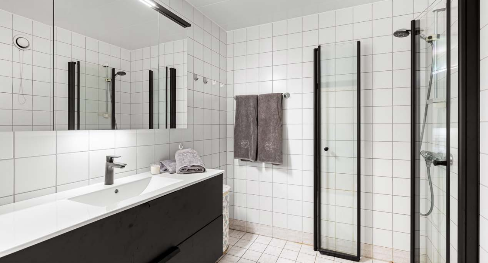
Heldekkende porselensservant med ettgreps servantbatteri og servantskap (2023). 3 speilskap med overliggende lyslist over servant (2023) og nye svingbare dusjdører i herdet glass (2024).
