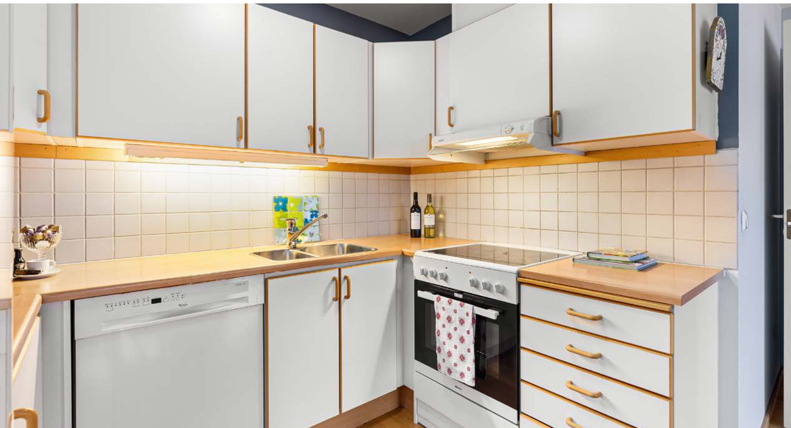
Kjøkkeninnredning har hvite fronter med bøkantslister. Det er mekanisk avtrekk over komfyr.
