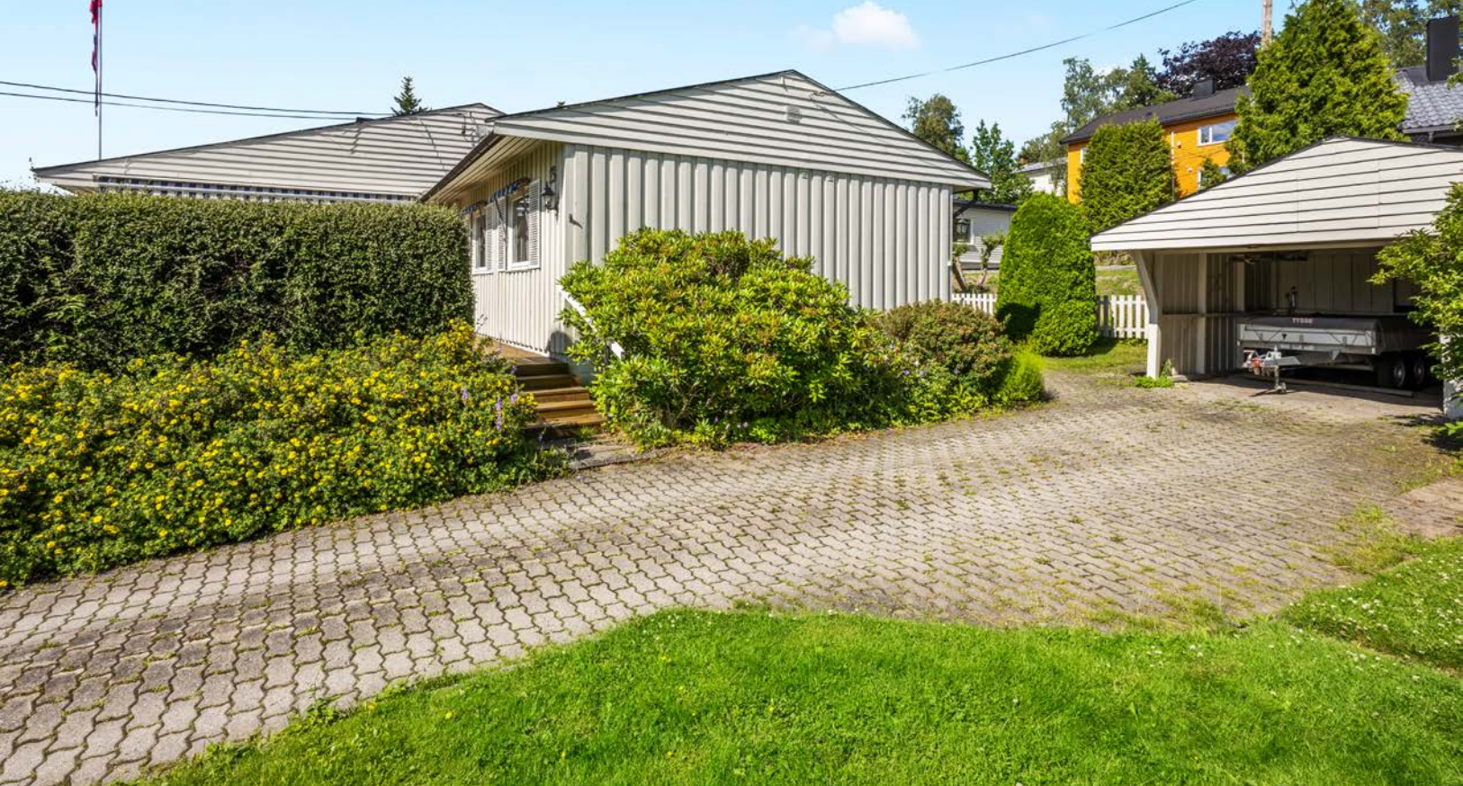
Steinbelagt gårdsplass med carport og tilhørende bod.
