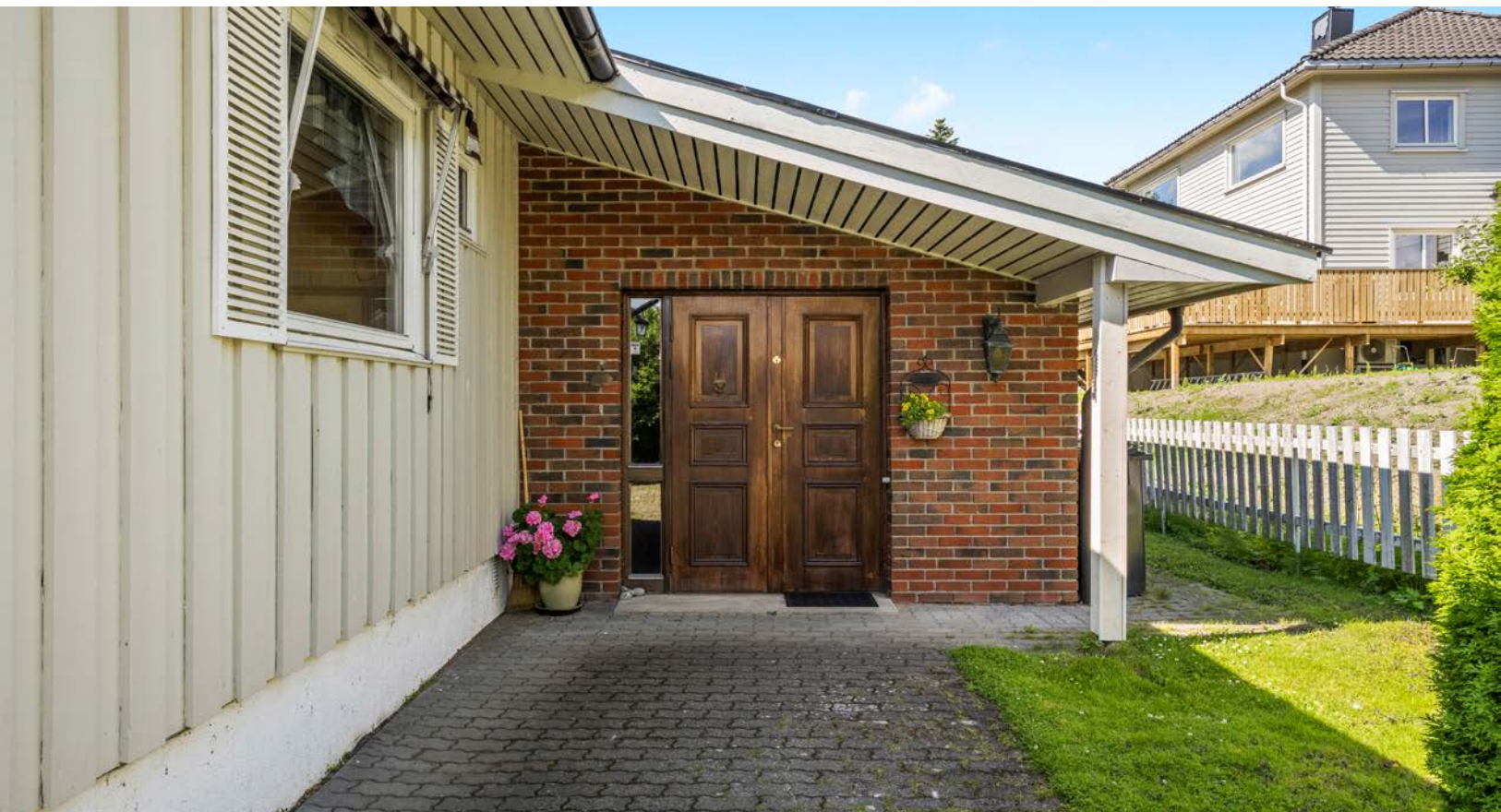
Inngangspartiet er overbygget og har varmekabler som sikrer trygg og tørr adkomst - fra inngangen til carport.
