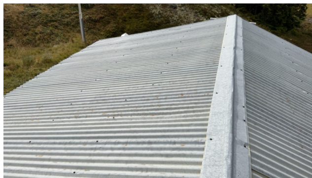
Taktekking er fra byggeår
