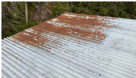
Rustskader på plater
