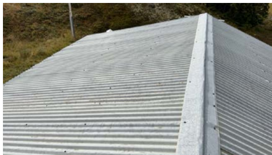
Taktekking er fra byggeår
