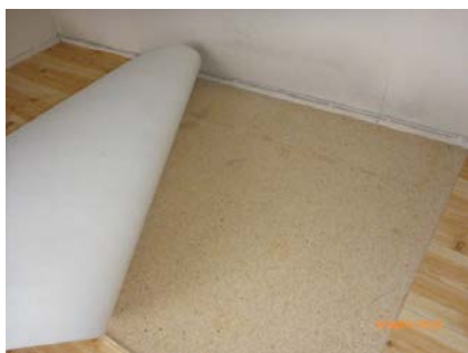
Gulv med løst belegg mot øst.
