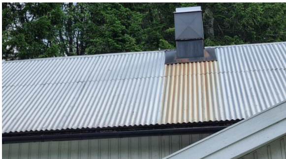
Taket er tekket med bølgeblikkplater.
