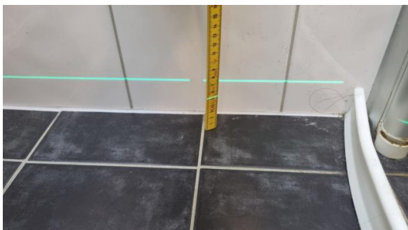
Kontroll av fall til sluk.
