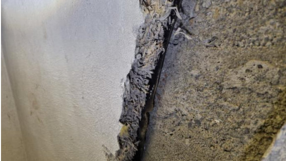
Grunnmurer er innvendig tekket med tresonitt og murpuss.
