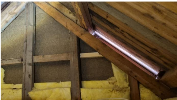
Luftespalte i gavelvegg.
