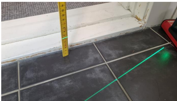
Kontroll av fall til sluk.
