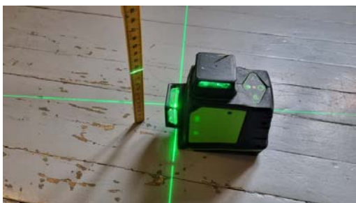
Kontroll av planavvik.
