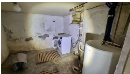
Oversiktsbilde av vaskerom.
