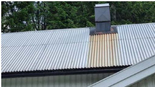
Taket er tekket med bølgeblekkplater.
