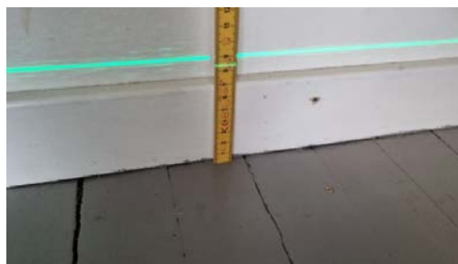
Kontroll av planavvik.
