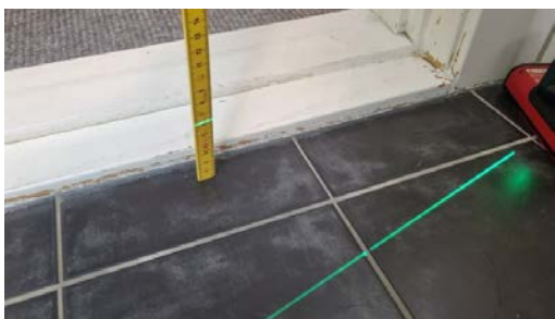
Kontroll av fall til sluk.
