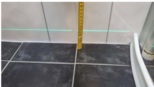
Kontroll av fall til sluk.
