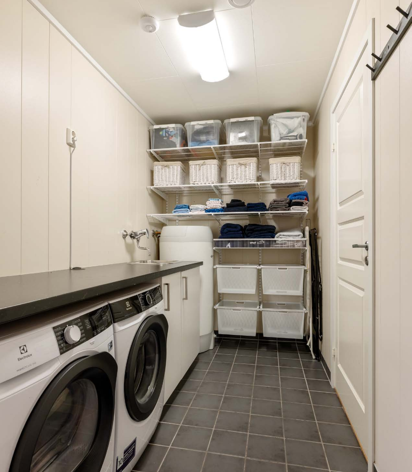
Vaskerommet er for øvrig innredet med benkeinnredning, skyllekum og opplegg for vaskemaskin og tørketrommel.
