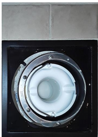
Våtrom - [Sluk bad]
