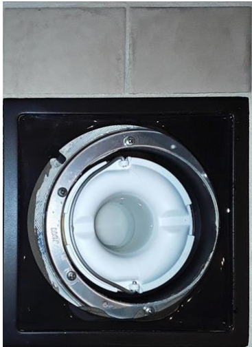
Våtrom - [Sluk bad]
