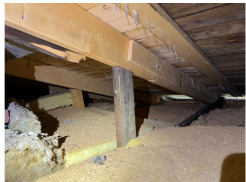
Ufagmessig utførelser av tiltak på takkonstruksjon
