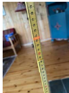
Planavvik er målt med laser, målt høyde 73,5 cm
