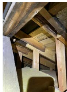
Ufagmessig utførelser av tiltak på takkonstruksjon
