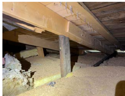
Ufagmessig utførelser av tiltak på takkonstruksjon
