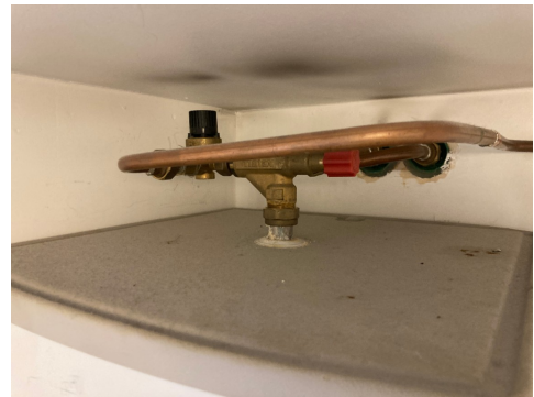
Merker etter varme i takplater
