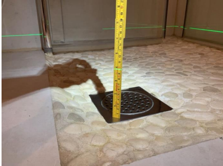
Målt fall til sluk: 45mm.
