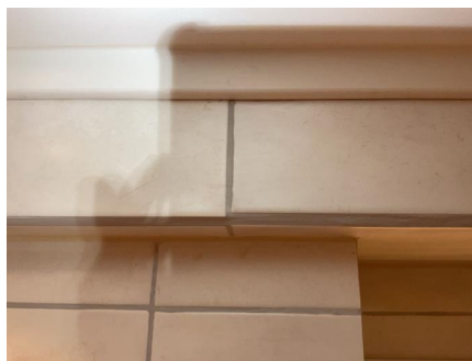
Ujevne overganger på fliser.
