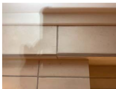
Ujevne overganger på fliser.
