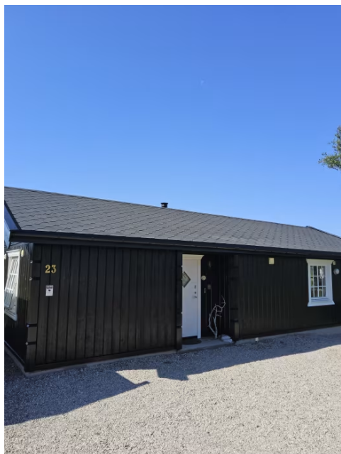
Bilde viser fasade på inngangsside.
