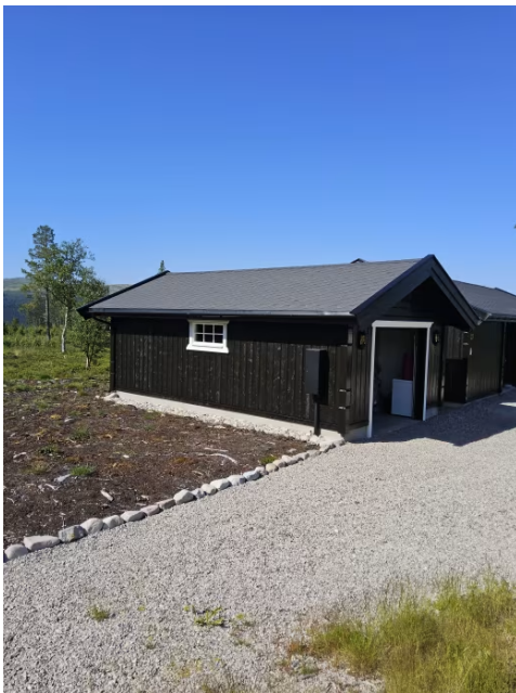
Bilde viser garasje.
