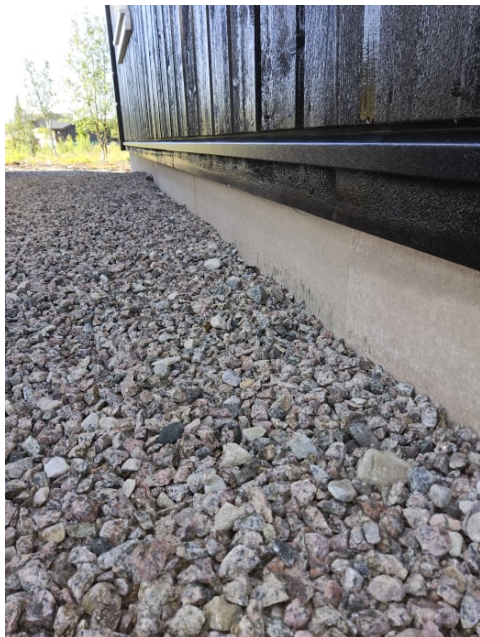
Bilde viser grunnmur.
