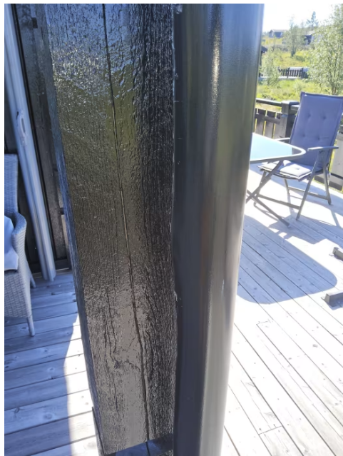
Bilde viser buling i taknedløp.
