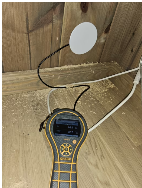
Bilde viser fuktmåling.
