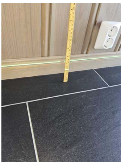
Bilde viser måling av etasjeskiller.
