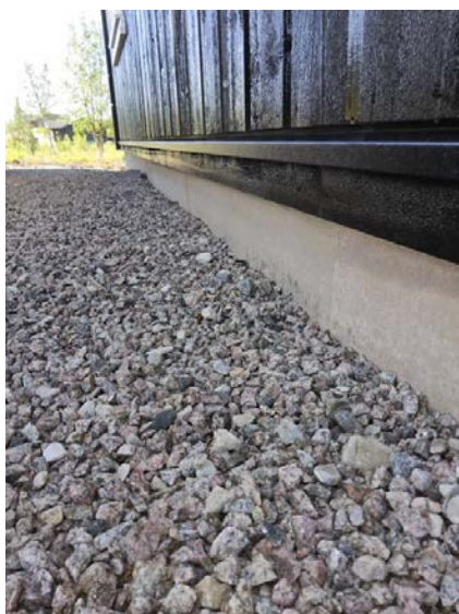
Bilde viser grunnmur.
