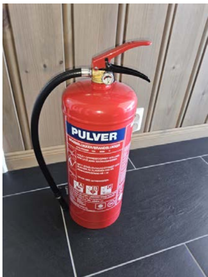
Bilde viser brannslukningsapparat.
