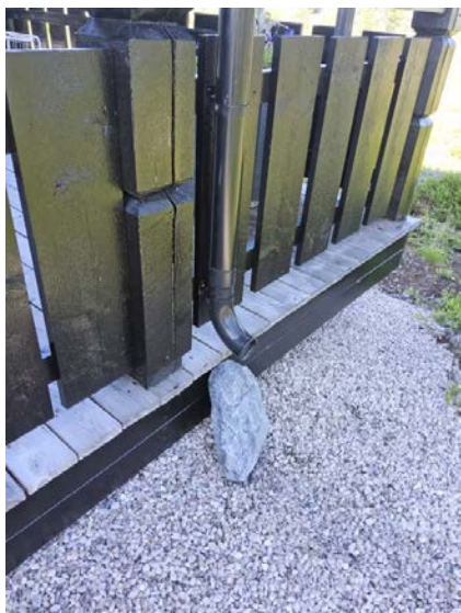
Bilde viser taknedløp avsluttet over bakken.
