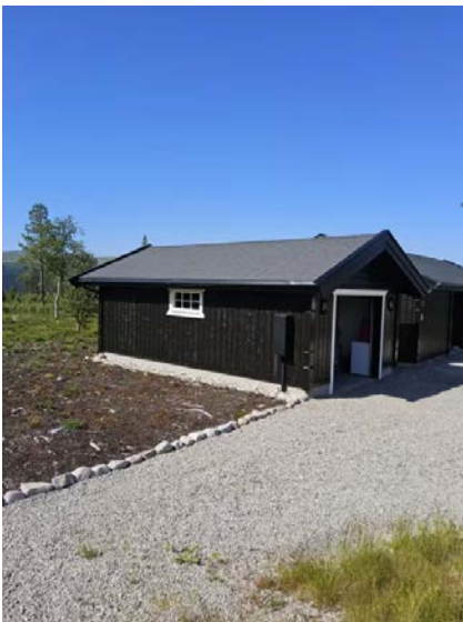
Bilde viser garasje.
