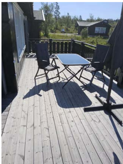
Bilde viser del av terrasse.
