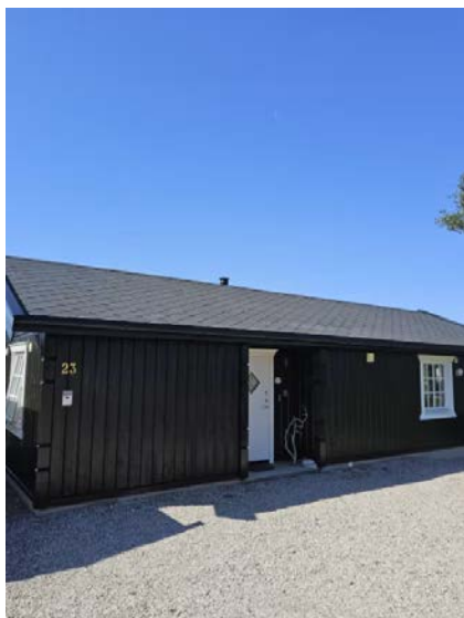
Bilde viser fasade på inngangsside.
