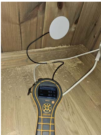
Bilde viser fuktmåling.
