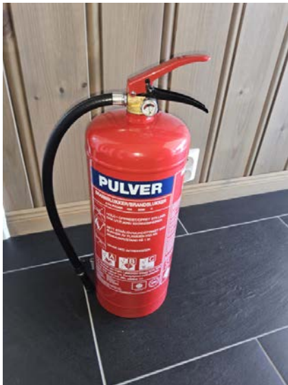
Bilde viser brannslukningsapparat.
