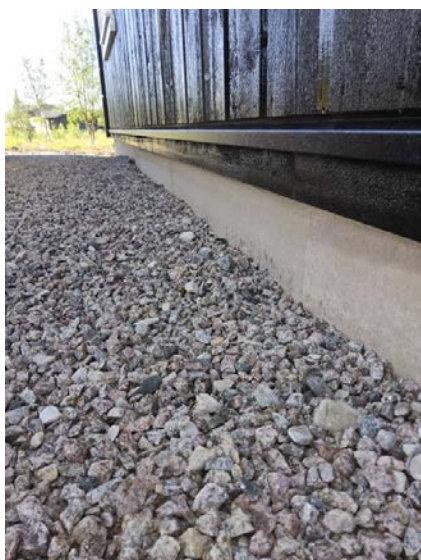
Bilde viser grunnmur.
