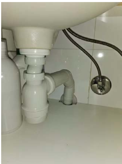
Bilde viser avløpsrør på bad.
