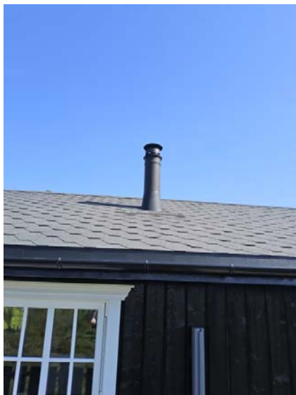
Bilde viser manglende takstige.
