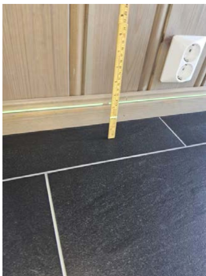
Bilde viser måling av etasjeskiller.
