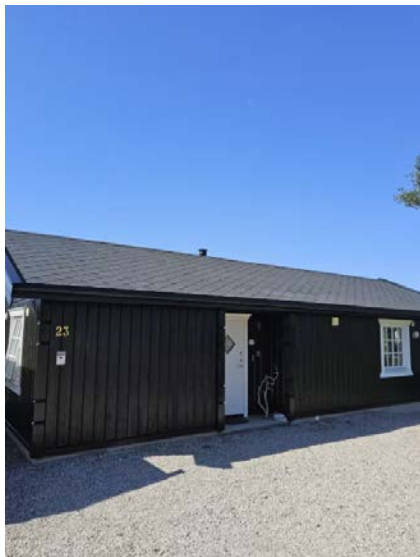
Bilde viser fasade på inngangsside.
