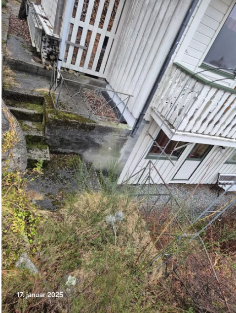
Avløp avsluttet høyt over bakken.
