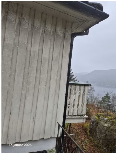
Svertesopp/avskallinger jevnt over.
