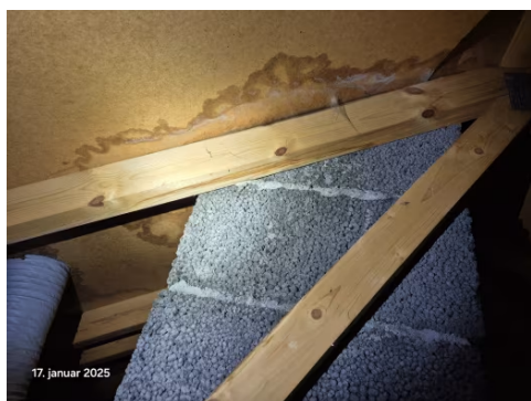
Fuktskjolder i undertak.
