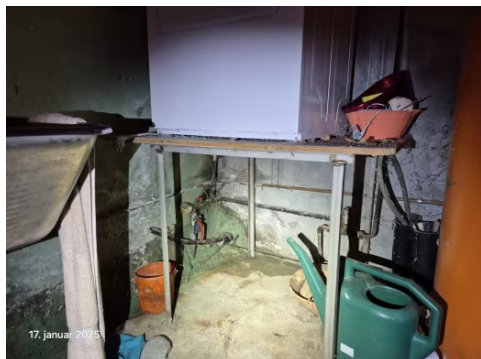
Vått rundt vannledninger i kjeller.
