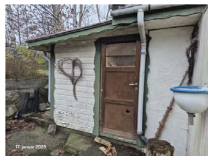
Slitt dør og slitte fasader.
