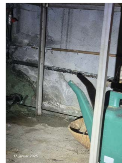
17. januar 2025 Tydelige tegn på fukt inne i garasjen.
