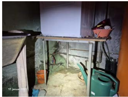
Vått rundt vannledninger i kjeller.
