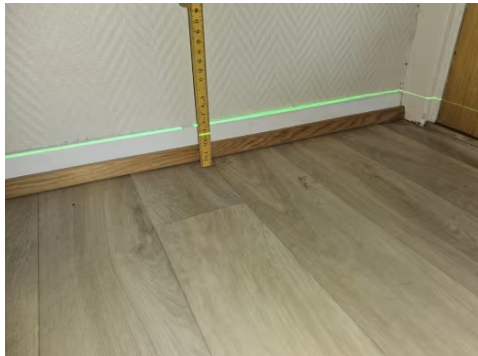
Etasjeskille ble kontrollert med nivelleringslaser.
