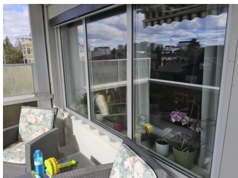
Vinduer og balkongdør er utvendig kledd med metallbeslag.
