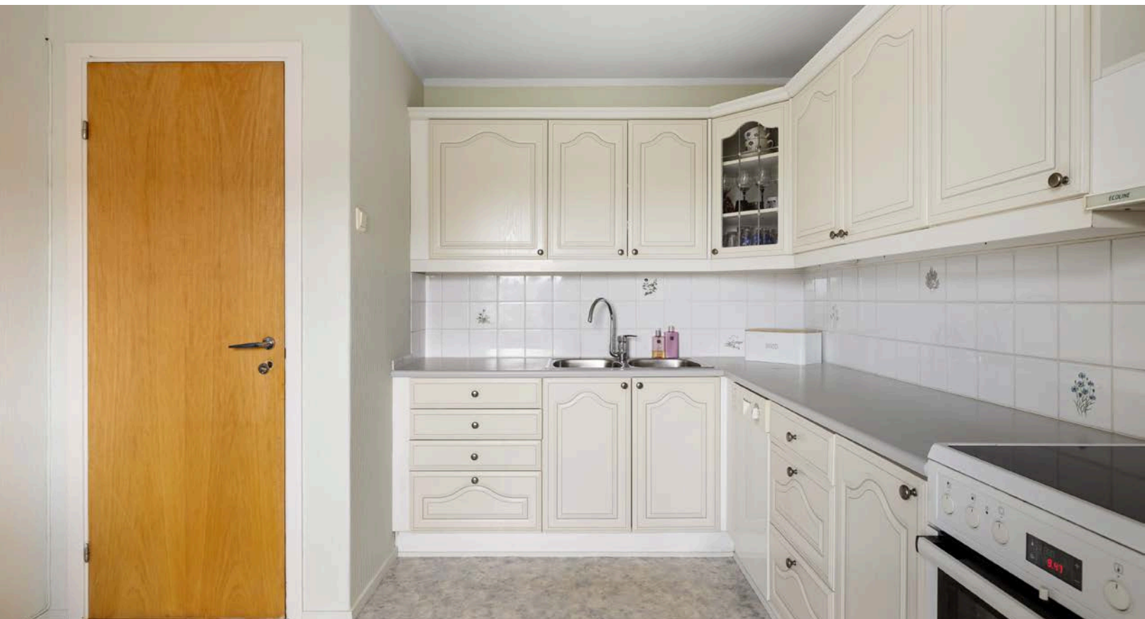
Innredningen har profilerte fronter og laminert benkeplate med nedfelt oppvaskkum. Praktisk med lyse fliser i benkeryggen og belysning under overskapene.
