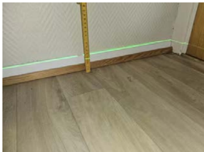
Etasjeskille ble kontrollert med nivelleringslaser.
