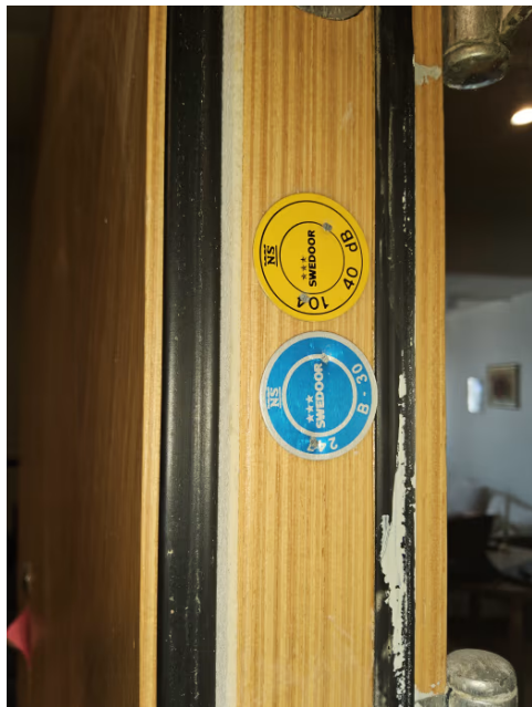
Bilde viser lyd og brannklassifisering på dør.
