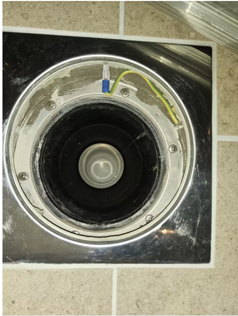
Bilde viser sluk på bad.
