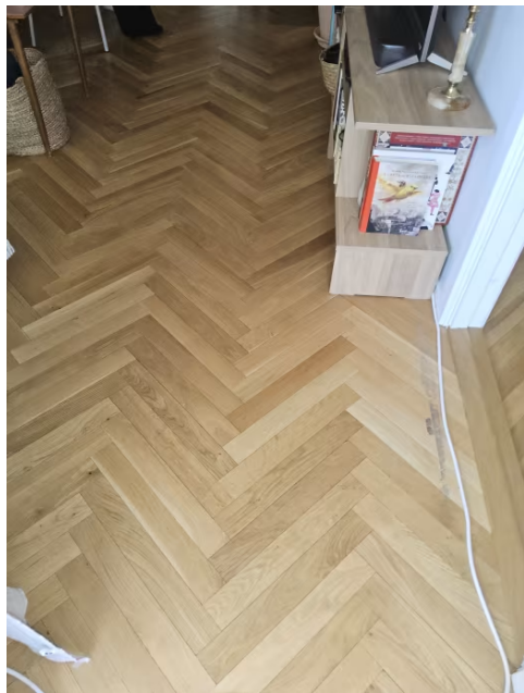
Bilde viser gulv/etasjeskiller.
