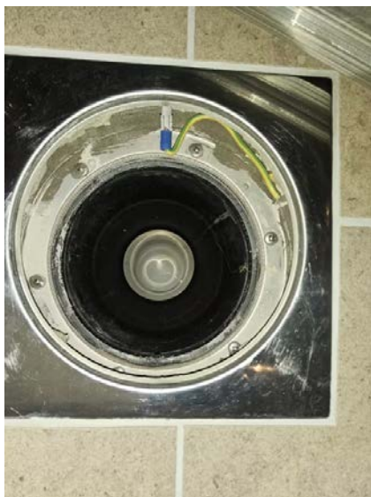
Bilde viser sluk på bad.
