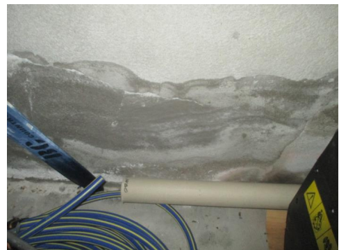
En del fuktmerker på grunnmur.
