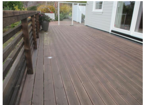
Deler av terrasse ut i fra stue.
