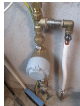
Innvendig stoppekran med vannmåler.
