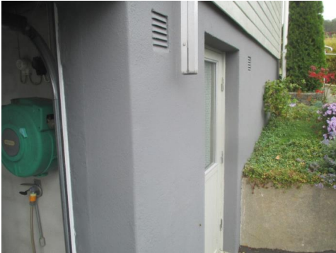
Deler av grunnmur.
