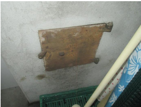
Sotluke i underetasjen.
