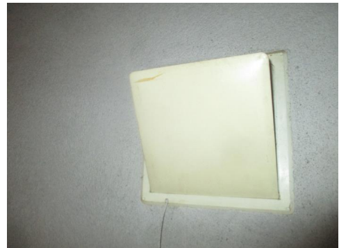
Ventil i grunnmur.
