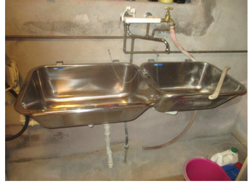
To nyere vaskekummer.
