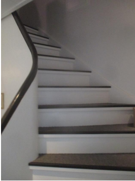
Trapp til loftet med tette opptrinn.
