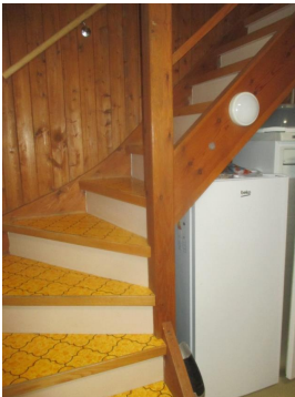
Kjellertrapp med tette opptrinn.
