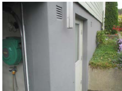
Deler av grunnmur.
