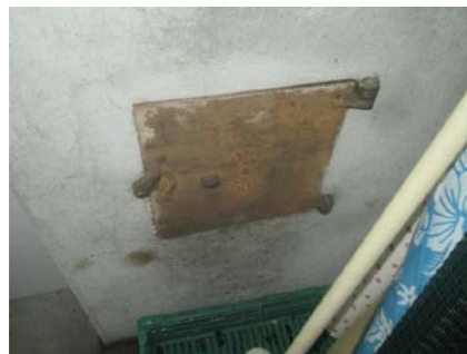
Sotluke i underetasjen.
