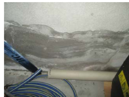
En del fuktmerker på grunnmur.
