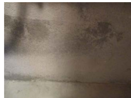
En del fuktmerker på grunnmur.
