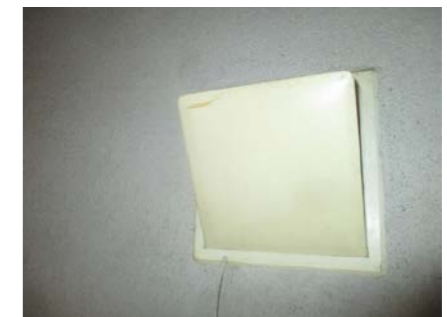
Ventil i grunnmur.
