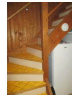
Kjellertrapp med tette opptrinn.
