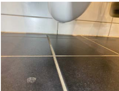
Drensåpning fra veggmontert toalett.
