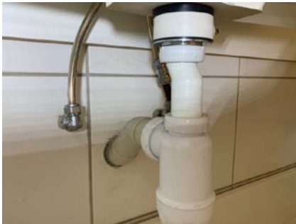
Kontroll av røropplegget.
