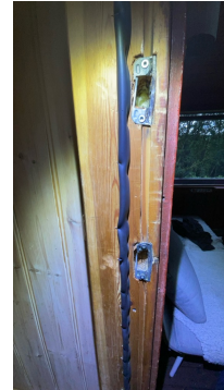
Bulkete beslag, sprekk i karm og ufagmessige tettelister.
