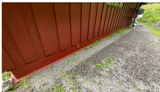
Kryperommet er ikke tilgjengelig/tettet.
