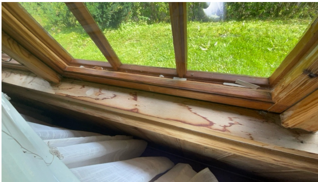
Løst kitt imellom glass
