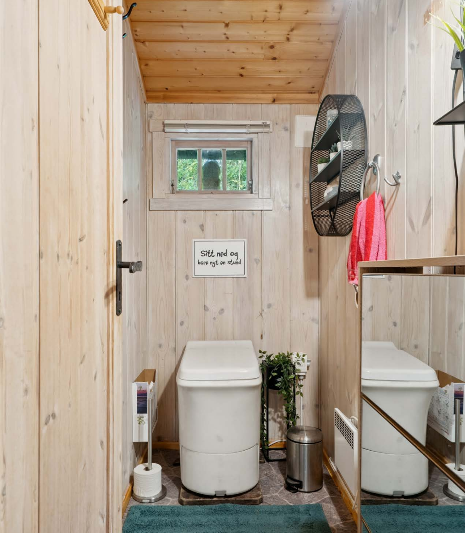
Toalettom med Cinderella forbrenningstoalett fra 2020.
